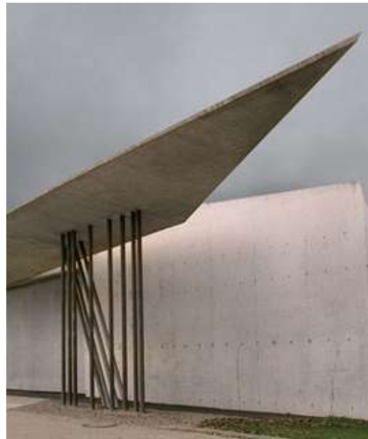
Рисунок 10 – Пожарная станция Vitra, арх. Заха Хадид, Вайль-на-Рейне, Германия, 1993
